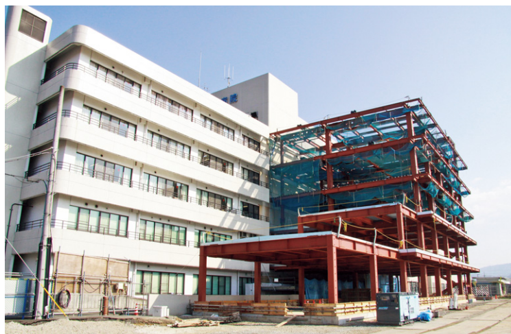
増築工事中の市立病院(南側から)
